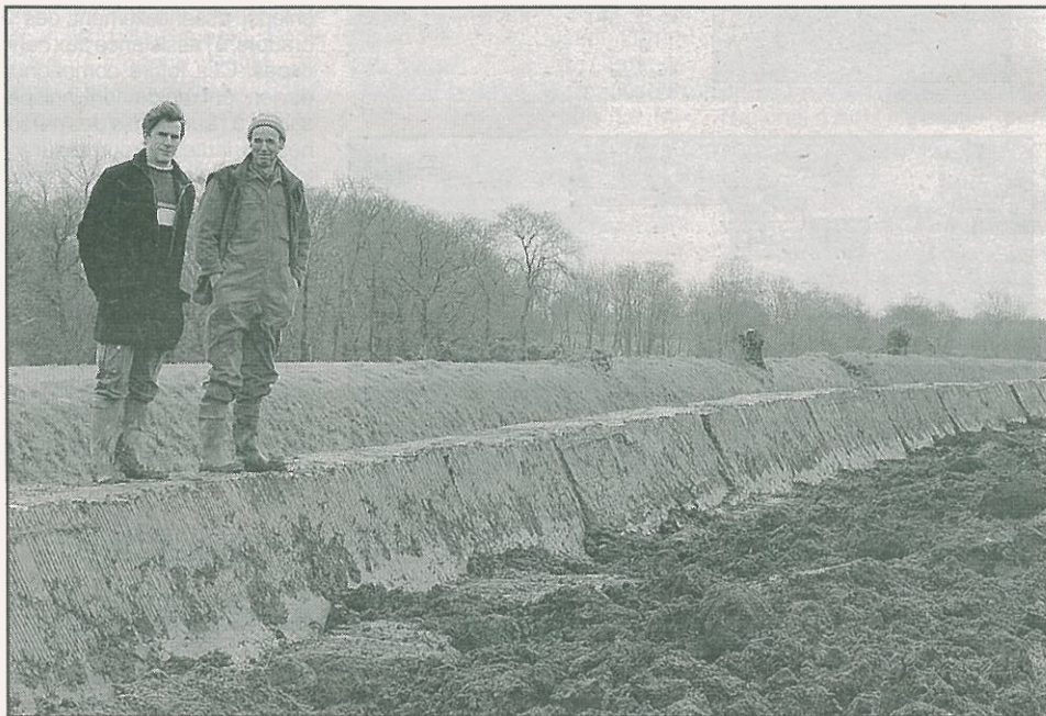
■ La pelleuse de la Sté Armoricaine de Travaux Publics vient tout juste de passer pour édifier le talus qui recevra des plantations d'essences locales.
